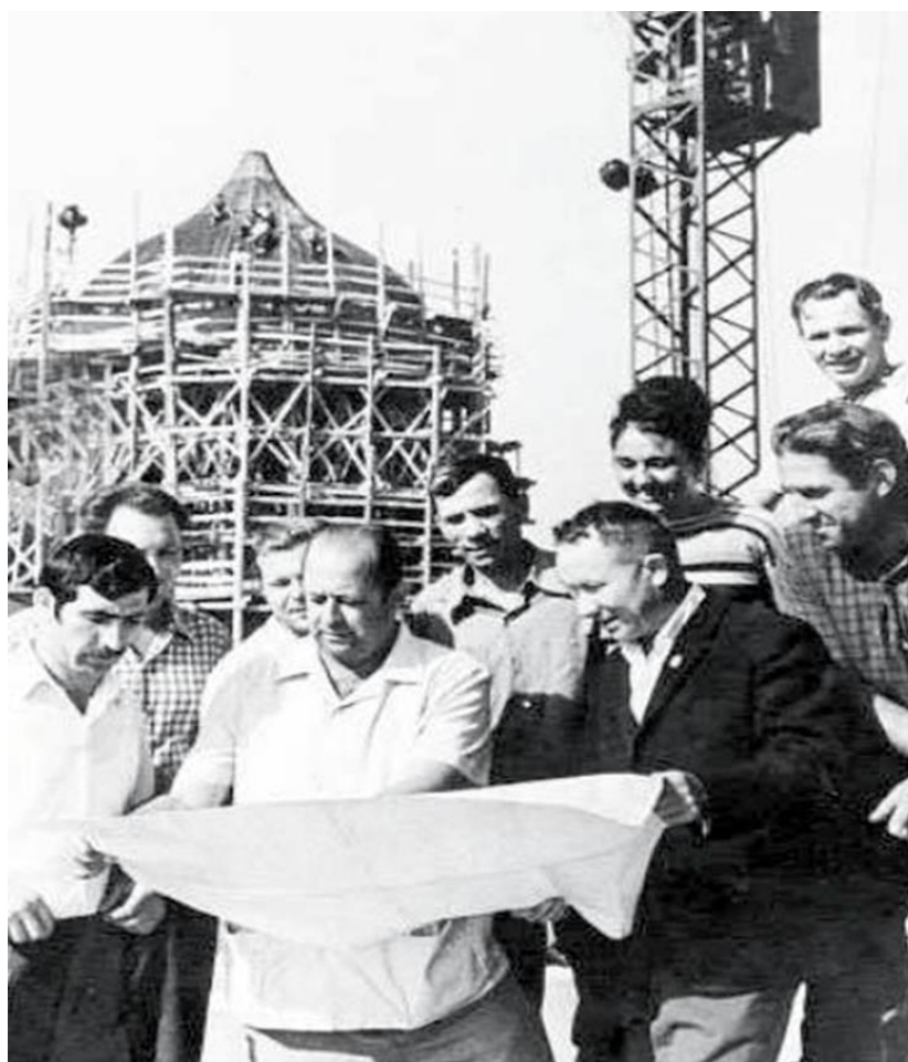
Рисунок 3 Строительство ресторана «Сосруко»
