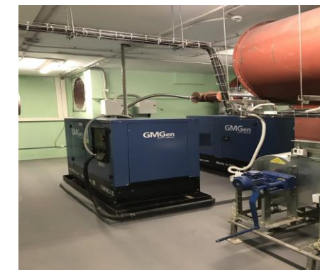
ул. Щербаковская, д. 38, помещение ГОиЧС
